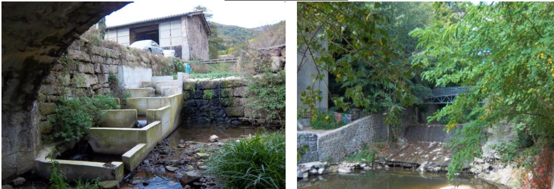
Figures 18 et 19 : Passe à poisson (bassins à jets plongeants) sur l'Yzeron à St Laurent de Vaux et seuil sur l'Yzeron à Francheville
